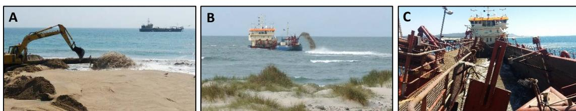
Figura 4. Técnicas de deposição através de draga: A) repulsão direta; B) repulsão por *rainbow*; C) abertura de porão.
